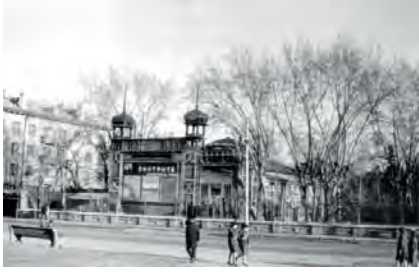
Деревянный кинотеатр в городском саду на ул. Гостинской
