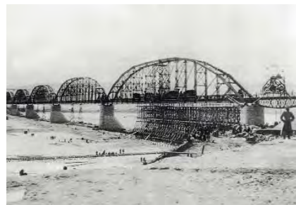
Железнодорожный мост через Енисей. 1897-1899 гг. Проектировал Л. Д. Проскуряков, строил инженер Е. К. Кнорре
