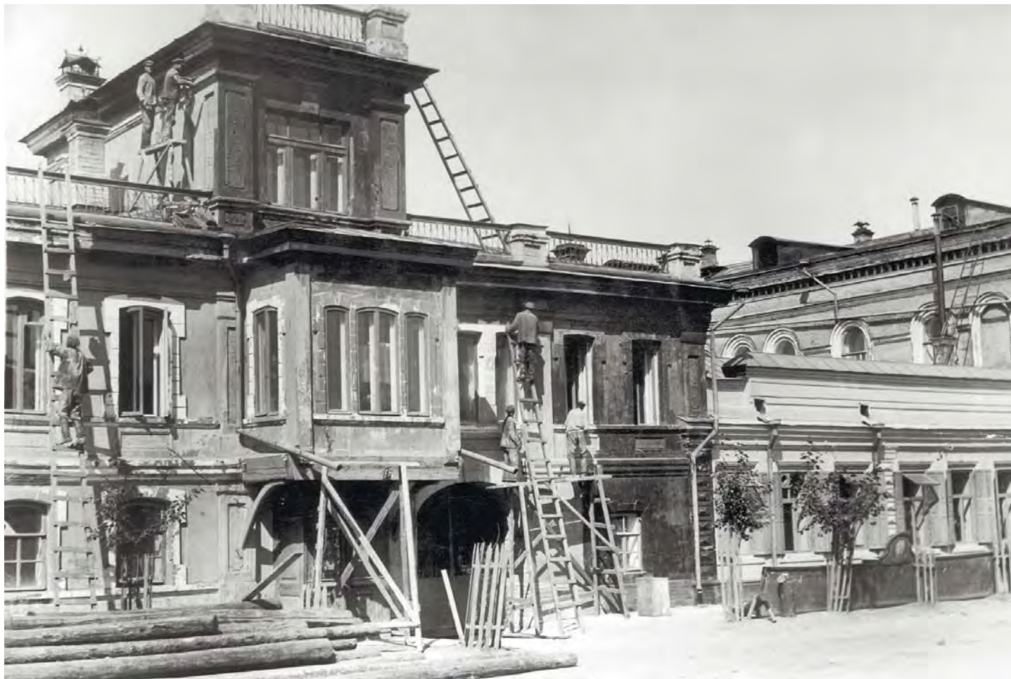
Ремонт дома купца Панаева В. Е. (1874) на Гадаловском переулке – Театральной улице (Фонды ККМ)
