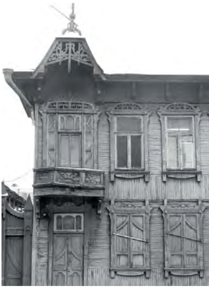
Угловой эркер деревянного дома усадьбы кутца Севастьянова (ул. К. Маркса, 118/Горького, 23)
