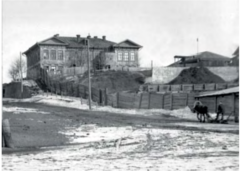
Дом на бутовой подпорной стенке по ул. Богграда у Покровского взвоза к Енисею
