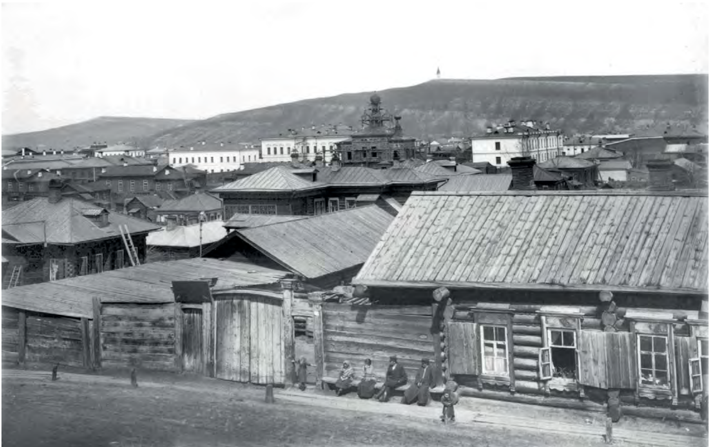
Вид на северо-запад в 1904 году (Фонды ККМ)
