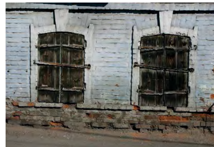
Ставки на шпонках посадского дома на подклете по ул. Сурикова, 18
