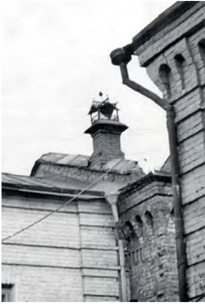
Фрагмент Торгового дома «А. Смирнов и сынъ» на ул. Гимназической/Большой (ныне – ул. Вейнбаума/Мира, 59)
