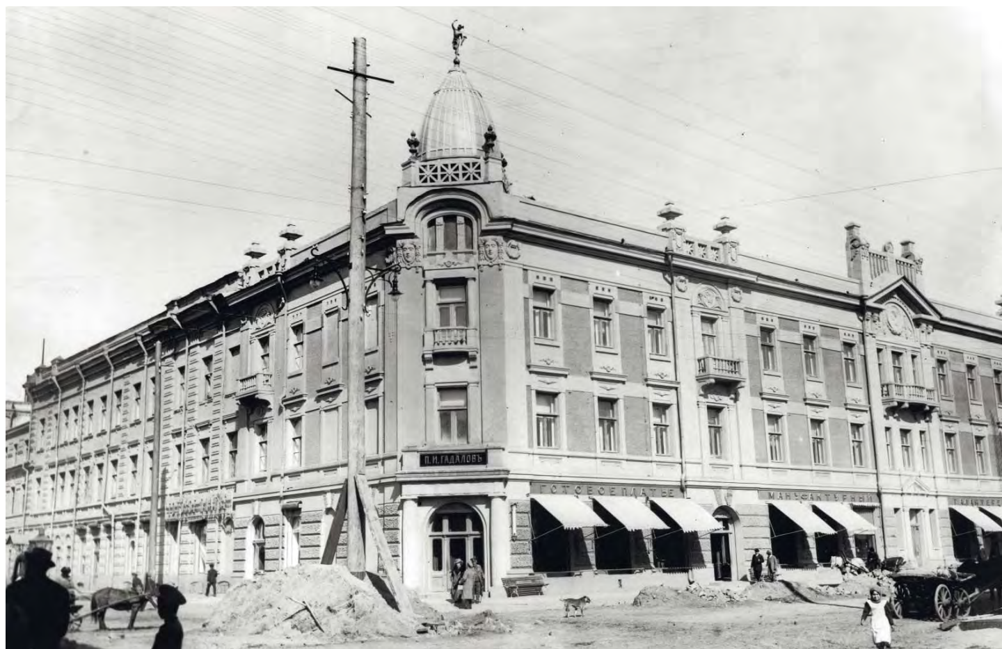
Торговый дом И. Г. Гадалова по ул. Воскресенской, 88–90. Реконструирован в 1913 г. архитектором В. А. Соколовским
