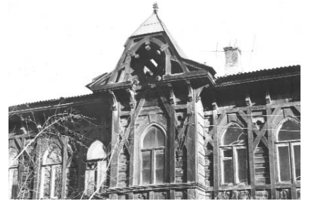
Фрагмент дома ксендза, ул. Декабристов, 22
