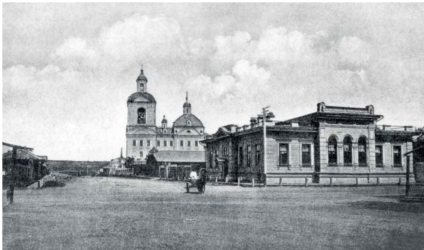
Вид деревянных домов Кузнецовского подворья от Пряничного заведения купца Матвеева на ул. Воскресенской
